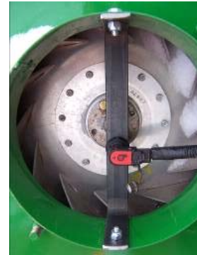
REM FAN SENSOR INSTALLATION
